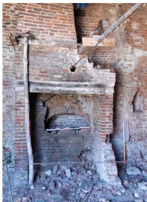
Aanzicht 19de-eeuwse haard met bakoven ingewerkt in voormalige gotische haard (ABO nv)
