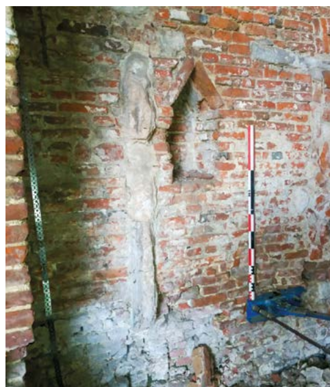
Detail gotische kaarsnis en natuurstenen wang van de voormalige gotische haard (ABO nv)
